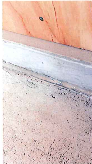
コンクリート打継部
