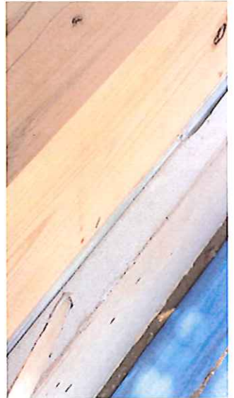
土台と基礎間
